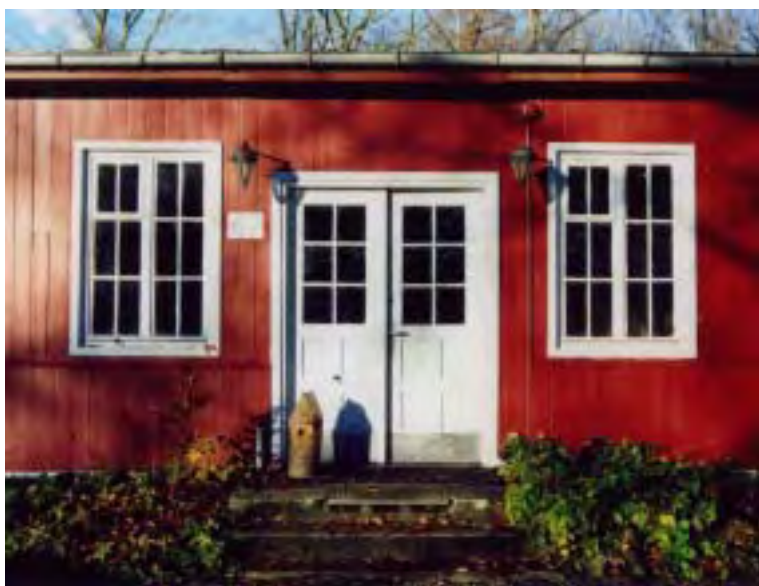
Indgangsdør på længdefacaden.
