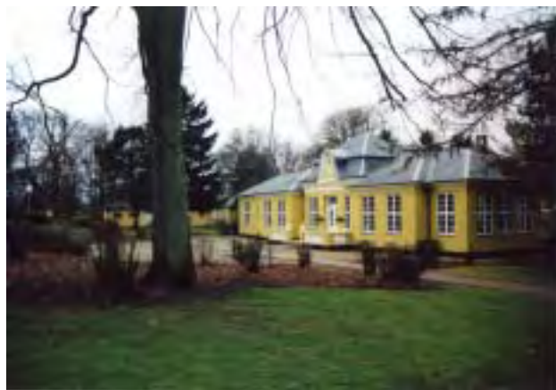
Bygning 5 set fra sydøst.
