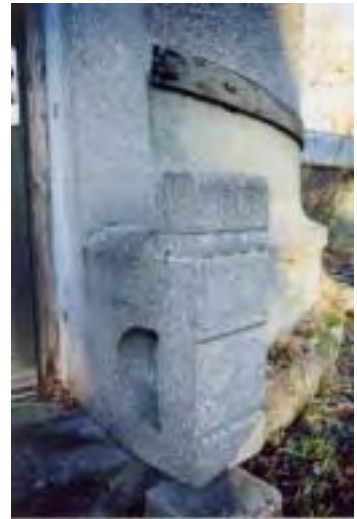
Afslutning ved bænke.
