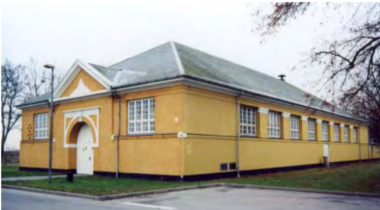
Facade mod nord og gavl mod øst.
